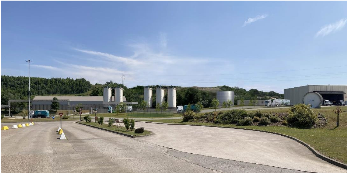
Vue de la nouvelle implantation des cuves de stockage de déchets liquides
